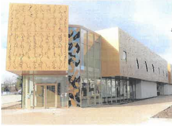
La façade du conservatoire
